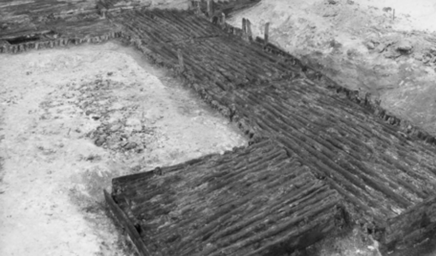
Flåtefundament for Olavskirken i Oslo, under utgravning på 1920-tallet. Foto: Gerhard Fischer, Riksantikvarens arkiv
