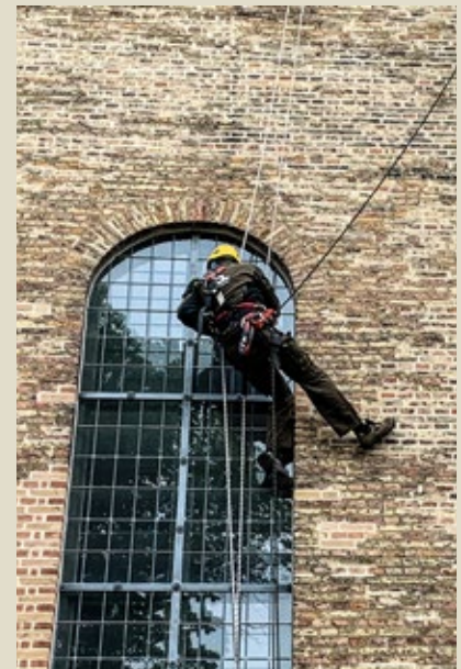
Inspeksjon i klatretau © KA
