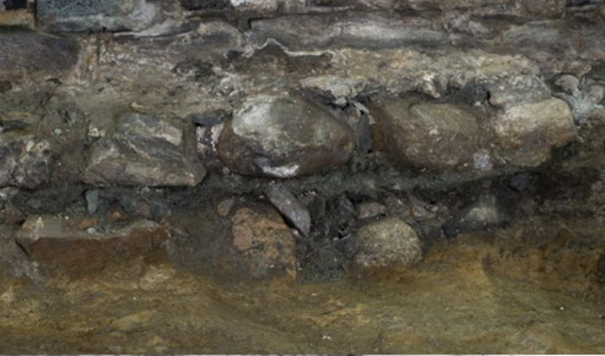
Stavanger domkirke, nordveggen i nordre tverrskip: Den vanligste måten å fundamenter steinkirker på var å grave grøfter ned til en hard undergrunn, hvor runde åkerstein ble lagt lagvis i sand eller løsmasser. I Stavanger domkirke var det også brukt knust kleberstein som avrettingsmasse mellom de ulike fundamentlagene. Foto: Kjartan Hauglid, NIKU
