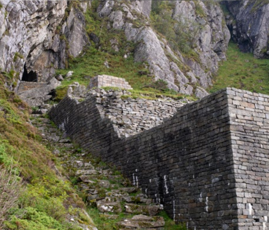
Sunnivakirken på Selja: For å kunne bygge den romanske steinkirken (øverst, midt i bildet) i nærheten av Sunniva-helleren (øverst til venstre) ble det bygget en enorm terrasse som fundament for kirken. Foto: Kjartan Hauglid, NIKU
