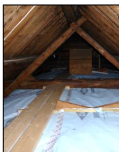
Isolert kaldt loft
