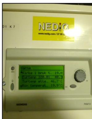
Betjeningspanel varmestyring
