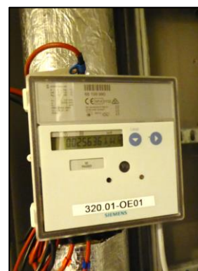
Energimåler varme til kirken
