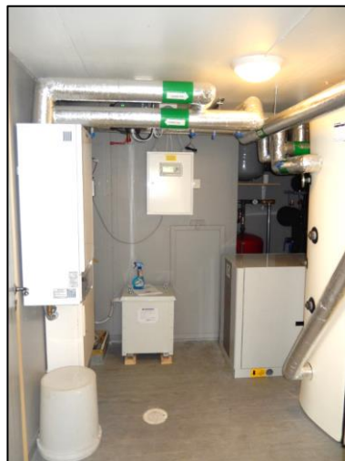
El-kjele, VP og akkumulatortanker
