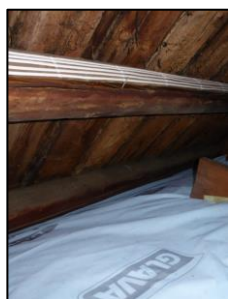
Isolering ned mot raft
