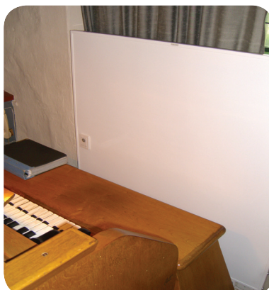
Varmeplate på vegg bak organist 750 W (type Mov med veggbraketter).
