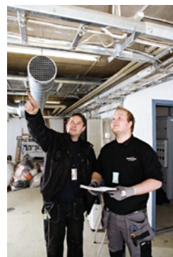
Visuell kontroll av kabler og fordelingsnett
