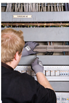
Visuell kontroll av utstyr i elektrisk tavle
