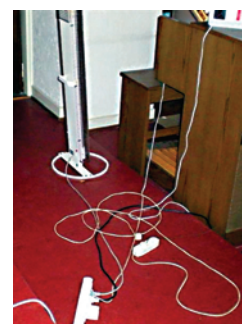
For mye bruk av bevegelig ledning
