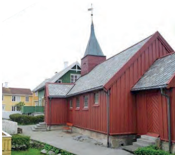
Figur 19. Grip stavkirke: Fasadekledning og tak av nyere dato beskytter de eldste delene.
