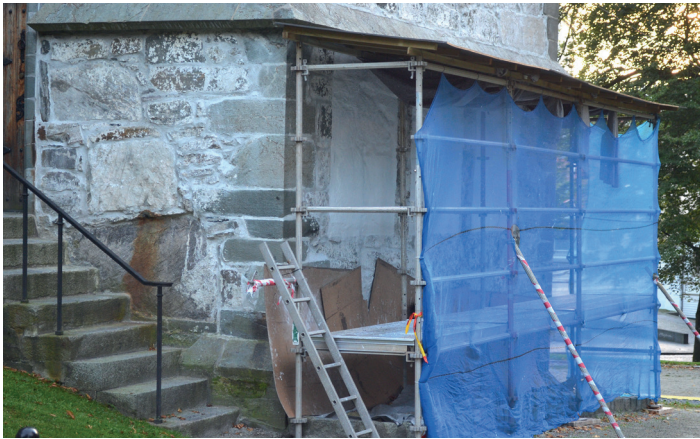
▲ Prøvefelt for kalkbehandling på Stavanger domkirke. Feltene er under tak til kalken har herdet, senere utsettes de for vær og vind for å teste holdbarhet
