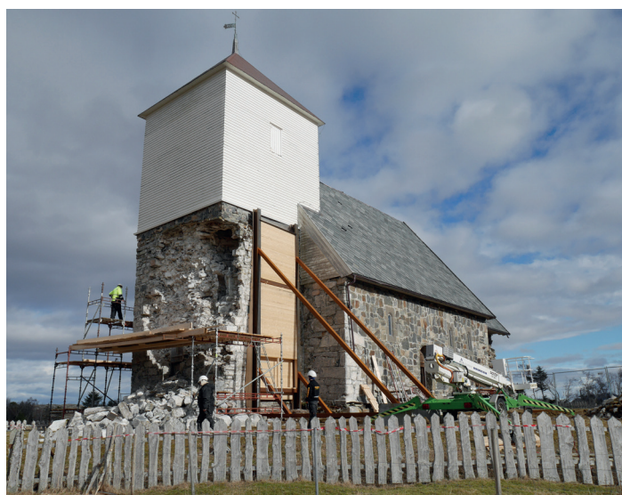
▲ Selv om de fleste middelalderkirker står støtt, forekommer det fortsatt utrasing av murverk av og til. Her Nærøy kirke i 2017: Foto: Eilertsen, Riksantikvarens arkiv
