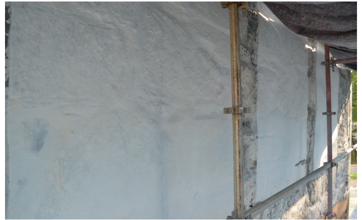
▲ Detalj av prøvefeltene, som viser tre ulike måter å pusse eller slemme veggene på.
