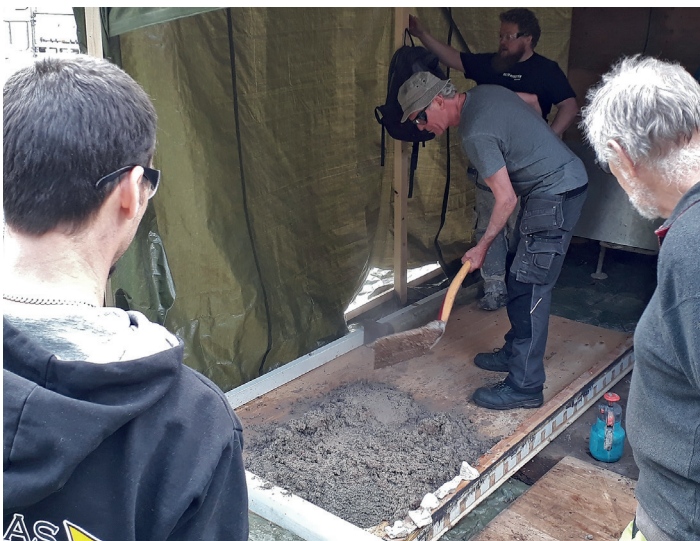
▲ Tradisjonell varmløsning av kalkmørtel med vedbrent kalk og sand på «gamlemåten», med spade. Løsningen/blandingen kan også gjøres i tvangsblender.
