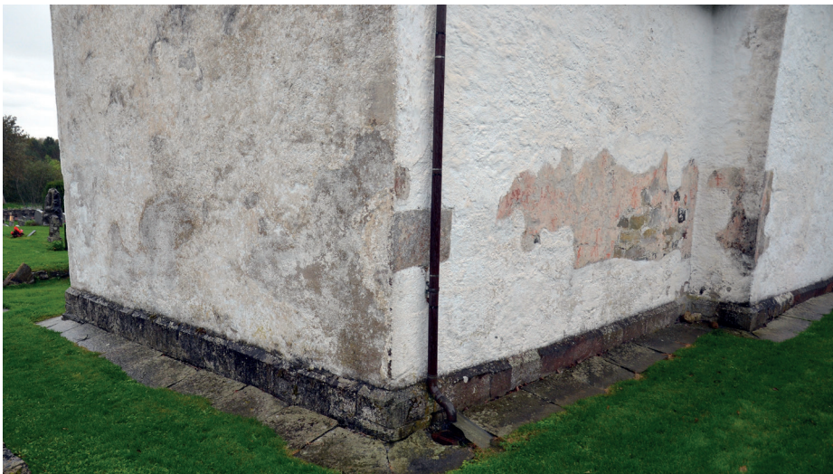
▲ Mange middelalderkirker har fått etablert ny drenering langs grunnmuren. Dreneringen krever jevnlig vedlikehold. Her den lukkede dreneringen omkring Moster gamle kirke
