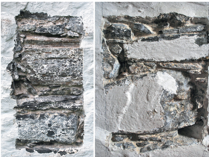
▲ Åpnede prøvefelter på Hesby kirke. Foto: Morten Stige, Fabrica
