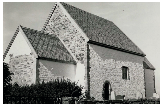
▲ 1969: Kirken er nesten ferdig behandlet med sementmørtel og tett og hard sementslemming. Foto: Stavanger Aftenblad, RAs arkiv
