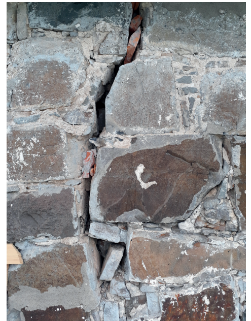
▲ En typisk sprekk i en gammel kirkemur. Sprekken følger minste motstands vei – gjennom et vindu og langs fugene. Tingelstad gamle kirke
