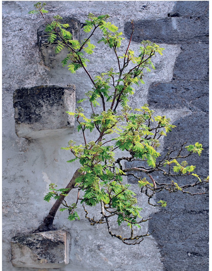
▲ Organisk vekst dreier seg ofte om svertesopp og alger, lav og mose. Men småtrær kan også vokse ut av fugene, og røttene kan sprengte i murverket. Her den gamle rogn på Hesby kirke. Den har blitt et symbol og skal ikke fjernes foreløpig
