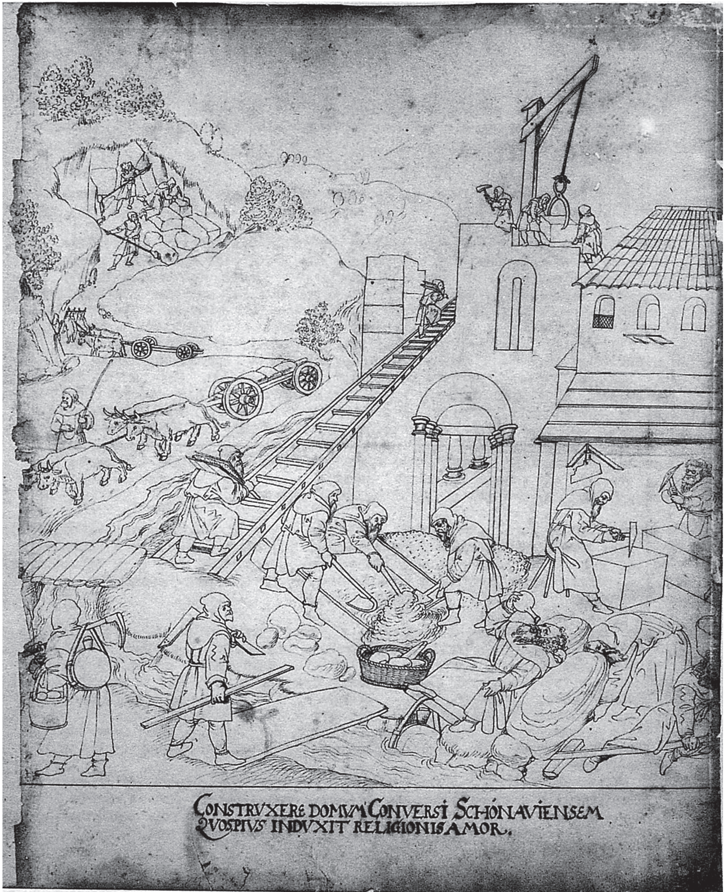
▲ Logistikken var ikke mindre krevende i middelalderen. Her ser vi bygging av cistercienserklosteret i Schönau (Schwarzwald, Tyskland). Denne tegningen fra ca. 1590 er utformet etter en eldre mal. Middelaldersk byggevirkosmhet i praksis: Steinbryting, transport med oksekjerrer, steinhogging, mørtelproduksjon, heising med kran, muring og flere andre aktiviteter. Det ser i dette tilfellet ut som det var klosterets lekbrødre, håndverkere som ikke var bestemt til å prestevies, som sto for byggingen (Eier: Germanisches Nationalmuseum Nürnberg, K 1532, Hz 195-204)
