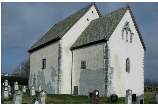
▲ 2013: Hele kirken er pusset med kalk og NHL, i flere omganger. Det går dårlig på den regnut-satte sørfasaden. Foto: Brevik, RAs arkiv
