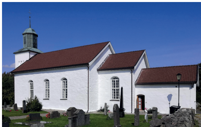
▲ Botne kirke ferdig istandsatt med kalk. Foto: Geir Magnussen
