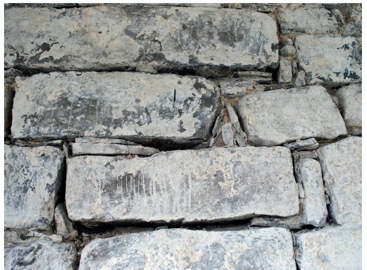
▲ Når sement er fjernet, skal skadd kalk meisles ned til man treffer på fingerfast materiale. Det er viktig å prøve å bevare pinningstein. Uthogd pinning tas vare på for ny bruk ved gjenoppbygging av fugene. Kinn kirke
