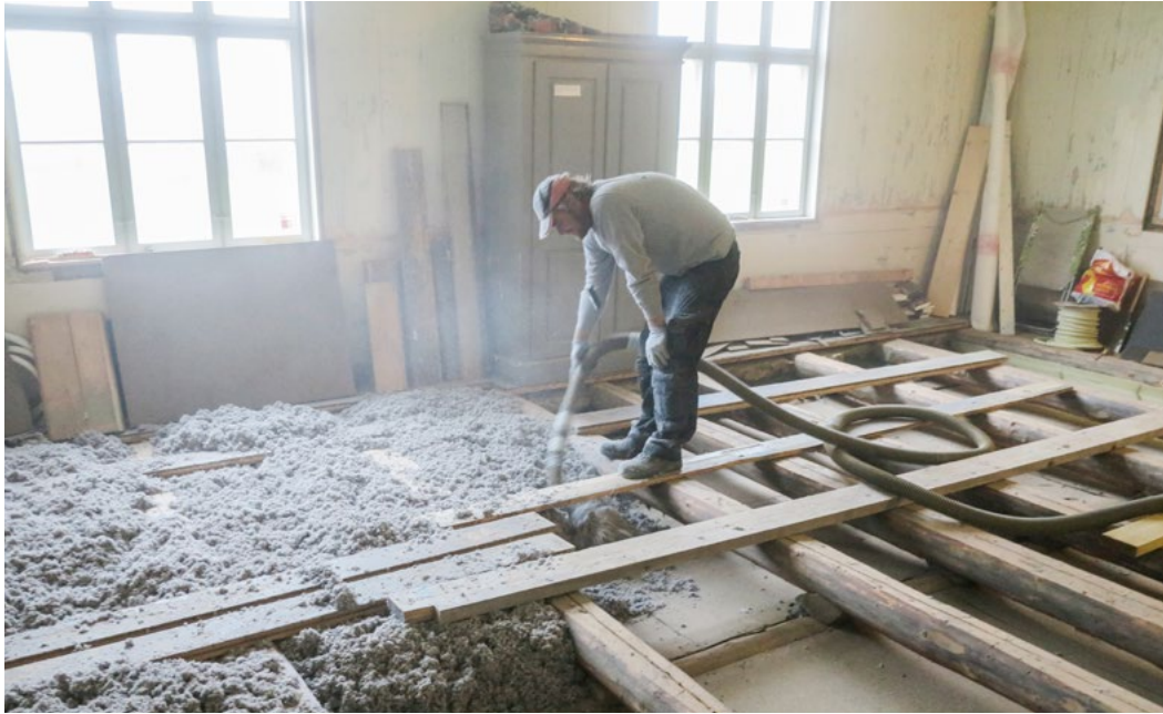
Innblåsing av celluloseisolasjon i etasjeskiller (gulvet) mellom kjeller og første etasje. Her er det originale gulvet tatt skånsomt opp og skal på plass igjen etter innblåsing.
