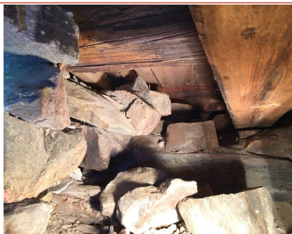
Eksempler på utgliding av steiner i tørrstablede fundamenter i kryperommet under kirkegulvet.
