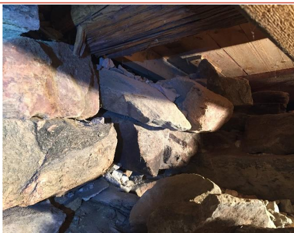
Eksempler på utgliding av steiner i tørrstablede fundamenter i kryperommet under kirkegulvet.
