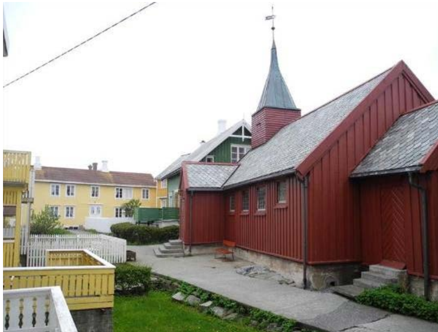
Figur 18 Grip stavkirke: Fasadekledning og tak av nyere dato beskytter de eldste delene
